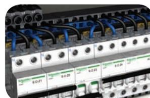
Распределительная система Multiclip позволяет быстро добавлять отходящие линии и выравнять фазы.
