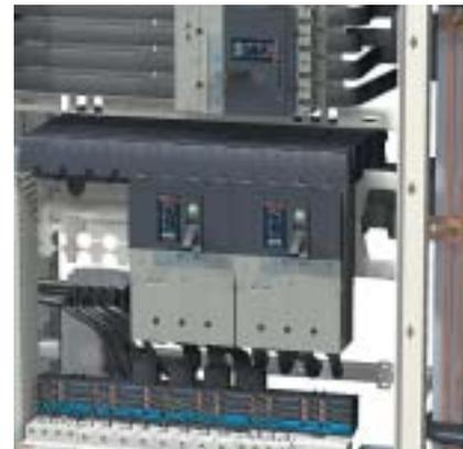
Пример: применение экрана с выключателем Masterpact NT позволяет свести к нулю необходимое безопасное расстояние над аппаратом и даёт реальную экономию места по высоте.
